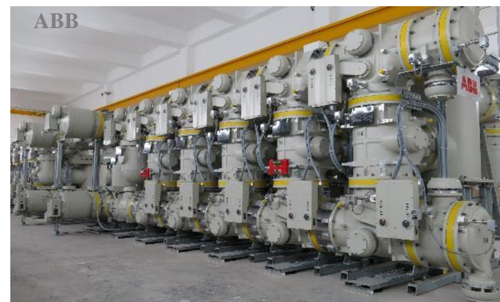
Obudowy stacji elektroenergetycznych GIS
